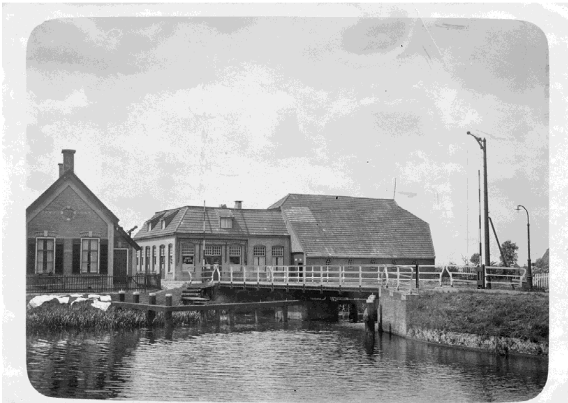
76. Bovensmilde, Norgervaart, rond 1930. Brug over de Norgervaart. De paal rechts is voor seingeving voor de scheepvaart, links boven de brugwachterswoning is het brugsein voor de tram zichtbaar. Foto
