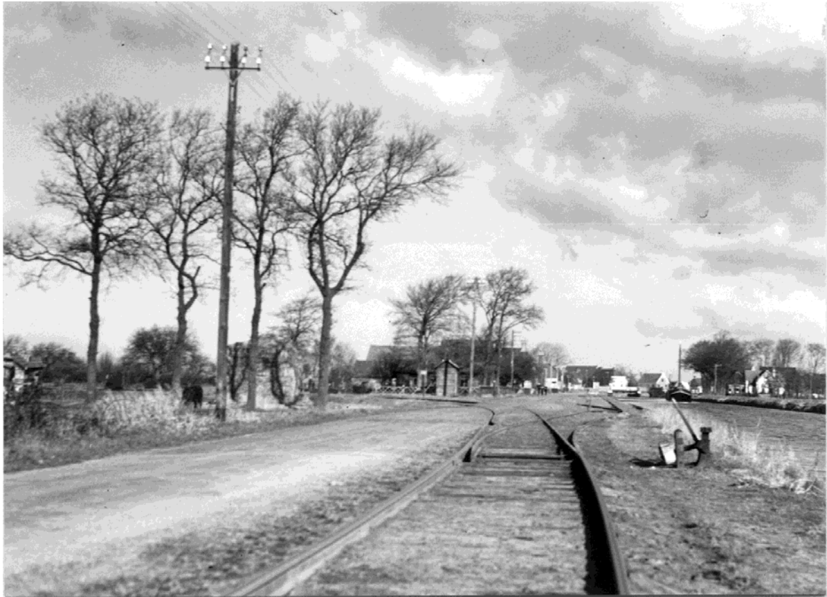
75. Bovensmilde, Norgervaart, december 1936. Rechtdoor de los- en laadplaats. Naar links de lijn richting Assen, achter de huizen langs. Foto : Foto: M. Wladimiroff, verzameling : L.J. Biezeveld
