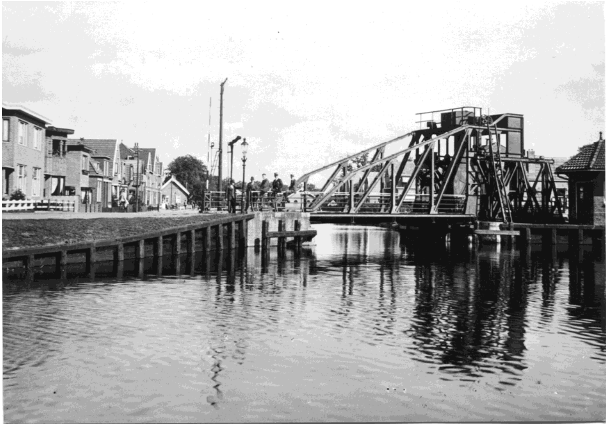
79. Assen, rond 1930. De elektrische rolbrug over het Noord Willemskanaal. Foto
