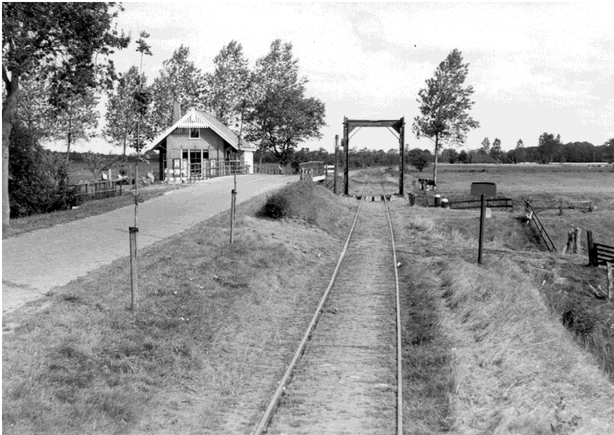
56. Tjongerbrug, 1 september 1962. De klapbrug voor het wegverkeer is al vervangen door een vaste brug. Voor en na de trambrug ligt (nu nog steeds) een duiker onder de tramlijn (en de weg). Foto R. Ankersmit
